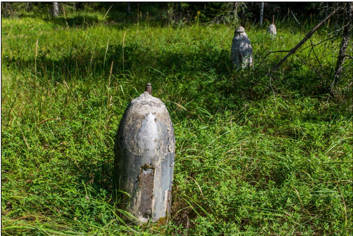
Foto 92 (228). Rutu raketibaas. Kolm lagunenud raudbetoonist posti, kõrgus 1 m, läbimõõt 30 cm. Dekoratiivelement?, piire? [29].
