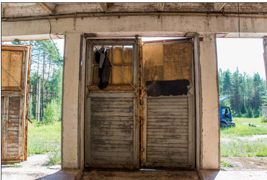
Foto 62 (145). Rutu raketibaas. Garaaž [17] Foto Mart Mõniste 5.08.2014.
