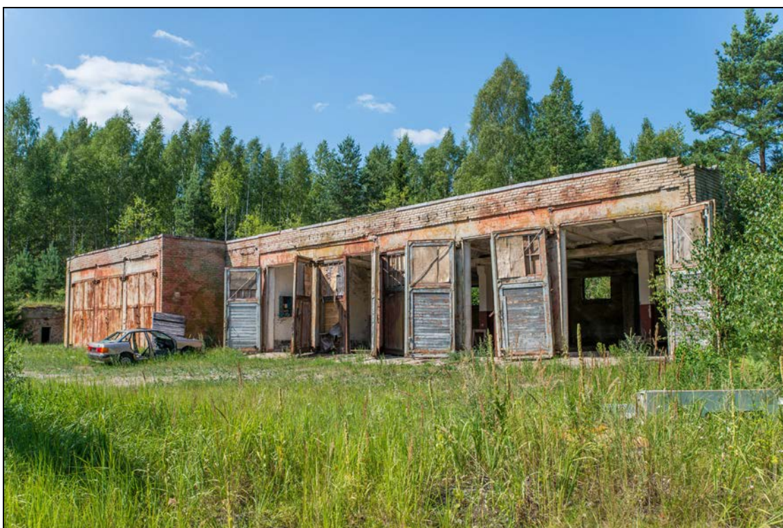
Foto 58 (146). Rutu raketibaas. Garaaž [17] Foto Mart Mõniste 5.08.2014.
