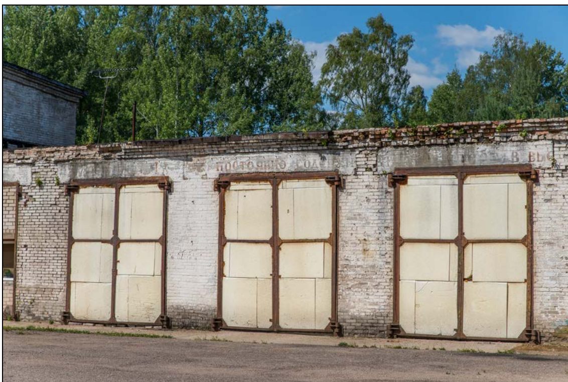
Foto 38 (115). Rutu raketibaas. Garaaž [9]. Foto Mart Mõniste 5.08.2014.
