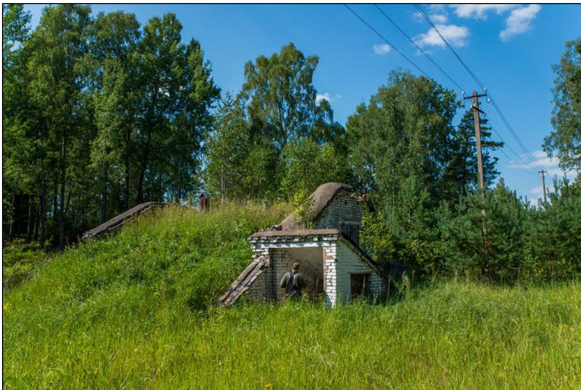
Foto 47 (246). Rutu raketibaas. Kelder [13]. Foto Mart Mõniste 5.08.2014.
