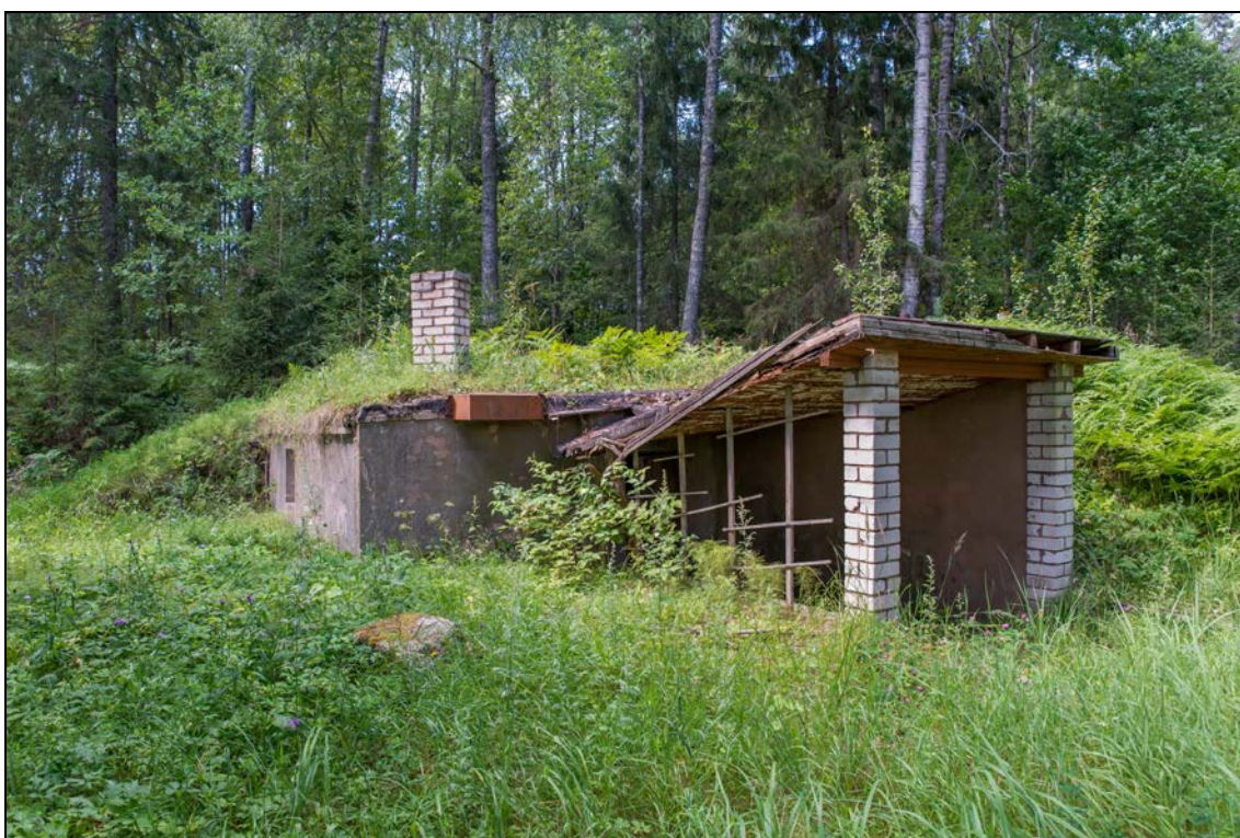
Foto 16 (026). Rutu raketibaas. Kelder [5]. Foto Mart Mõniste 5.08.2014.
