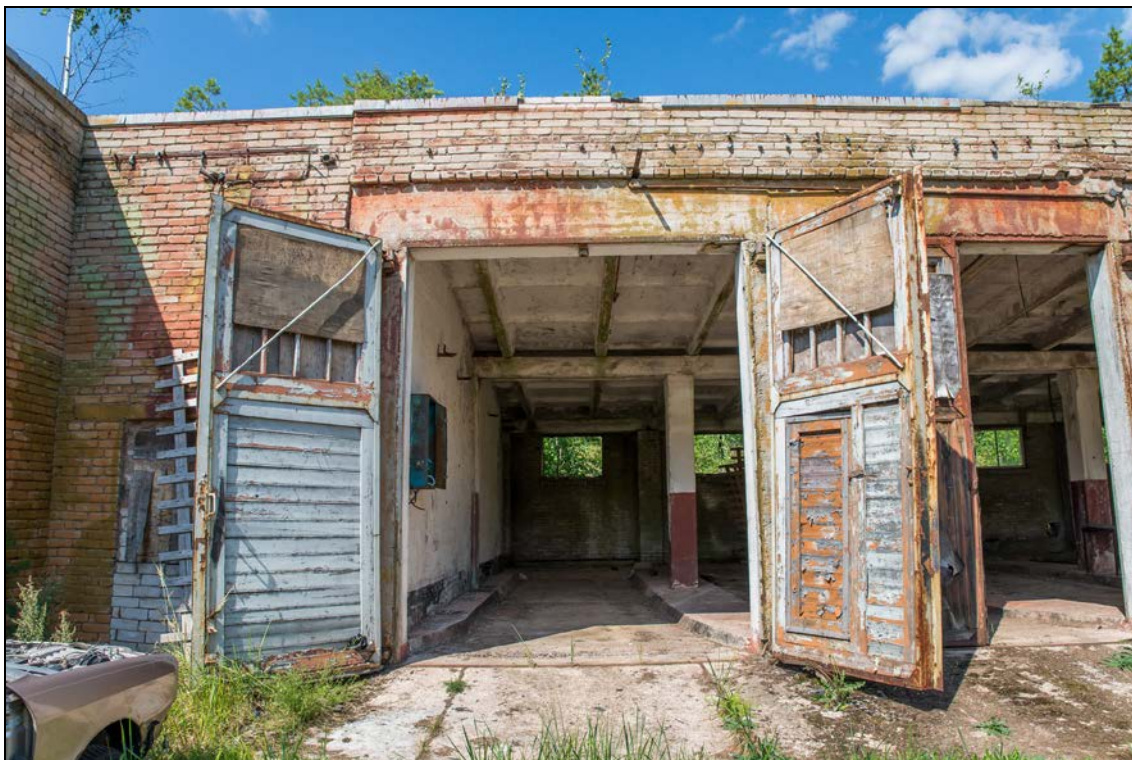
Foto 59 (139). Rutu raketibaas. Garaaž [17] Foto Mart Mõniste 5.08.2014.
