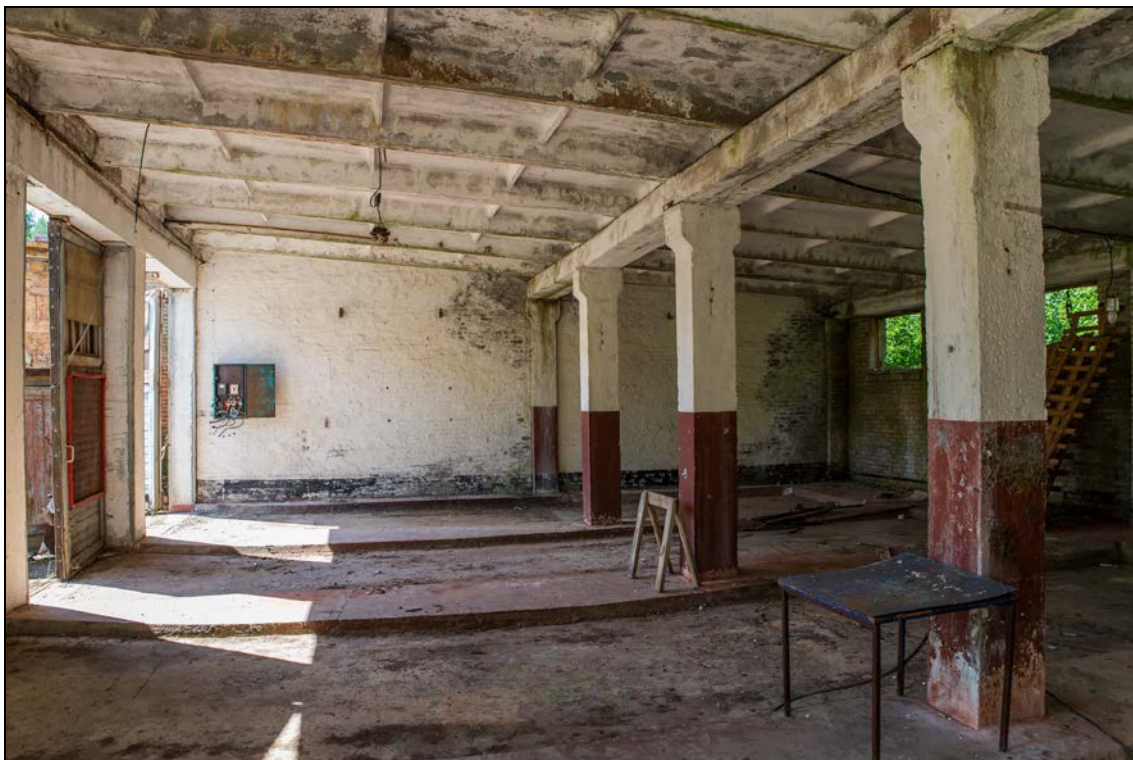
Foto 61 (). Rutu raketibaas. Garaaž [17] Foto Mart Mõniste 5.08.2014.
