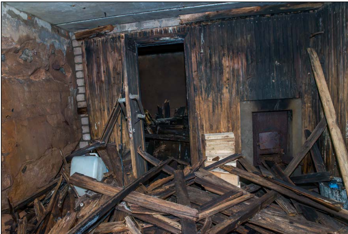
Foto 18 (029). Rutu raketibaas. Kelder [5]. Niiskusest on kogu puitvooderdus täielikult pehastunud.
