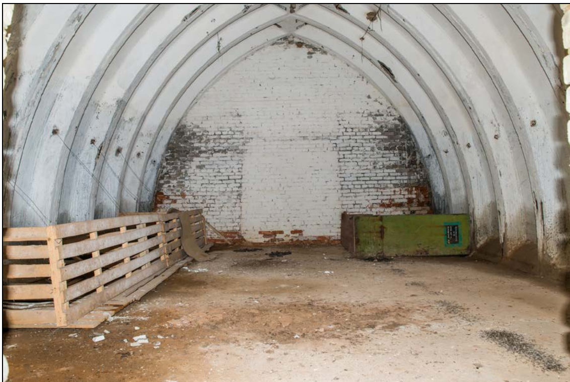
Foto 49 (255). Rutu raketibaas. Kelder [13]. Foto Mart Mõniste 5.08.2014.
