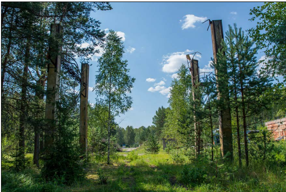
Foto 69 (151). Ruhu raketibaas. Betoonpostid [20], vaade [21] suunast. Foto Mart Mõniste 5.08.2014.
